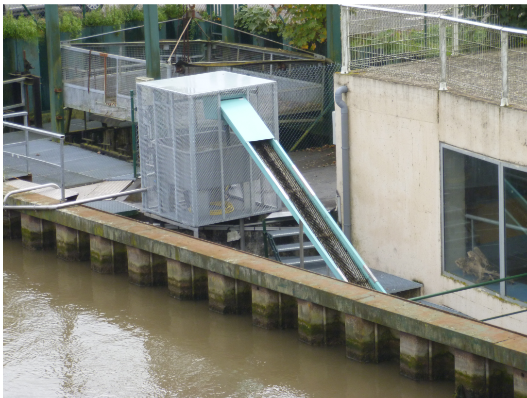
FIGURE 12 – Passe piège à anguilles en rive gauche du barrage de Poses - Amfreville-sous-les-Monts
