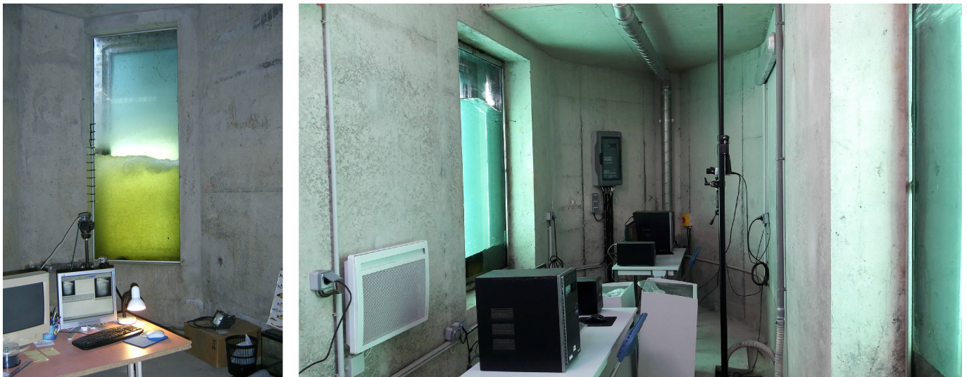
FIGURE 8 – Chambres de vidéo-comptage de la station de contrôle des migrations du barrage de Poses - Amfreville-sous-les-Monts. A gauche, chambre de la rive gauche ; à droite, chambre de la rive droite
