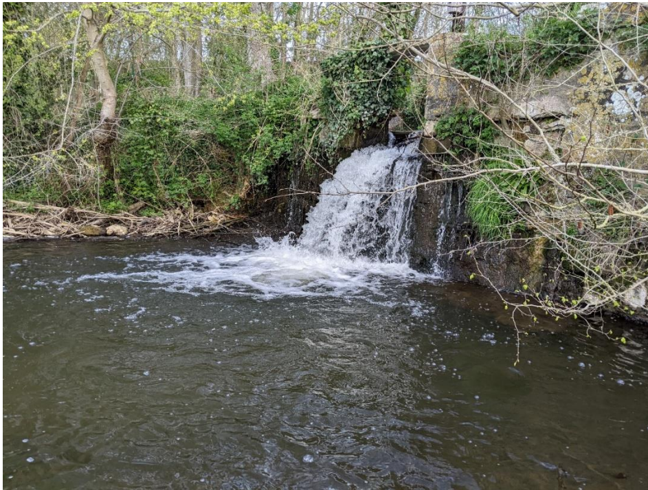
Figure 7 : Ouvrage sur le petit Odon (Seinormigr, 2022)
