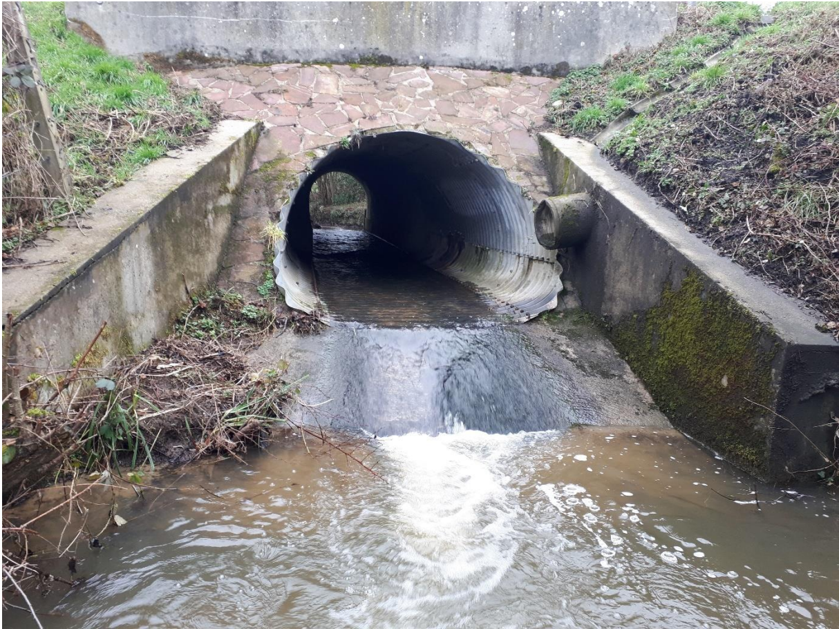
Figure 19 : Ouvrage de la RN 175 (ROE 6172) sur le Douet Eudes
