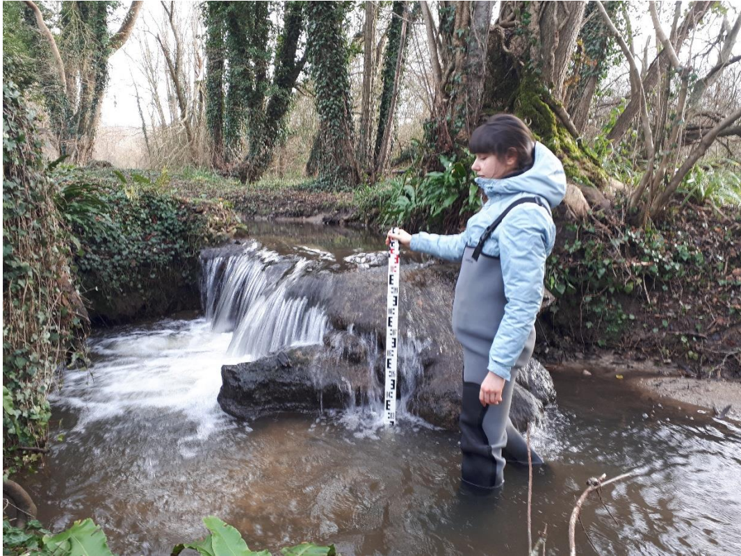
Figure 20 : Ouvrage non recensé et difficilement franchissable sur le Ruisseau de la Fontaine Saint Martin
