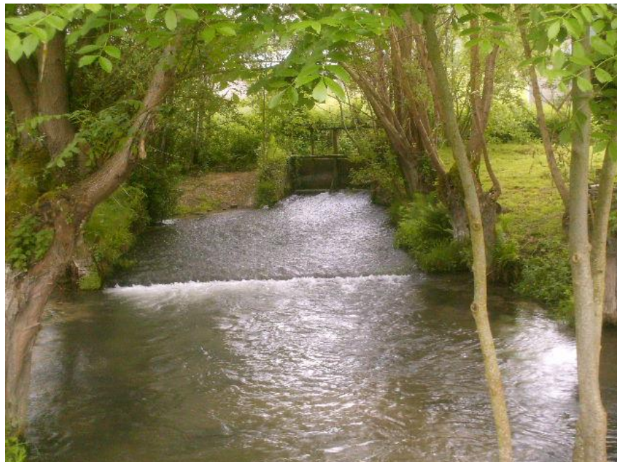
Figure 16 : Vannage de décharge du moulin de Launay
