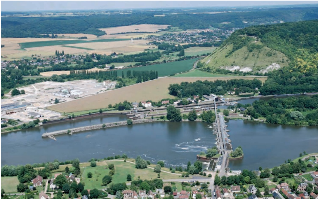
FIGURE 4 – Vue aérienne du barrage et des écluses de Poses - Amfreville-sous-les-Monts
