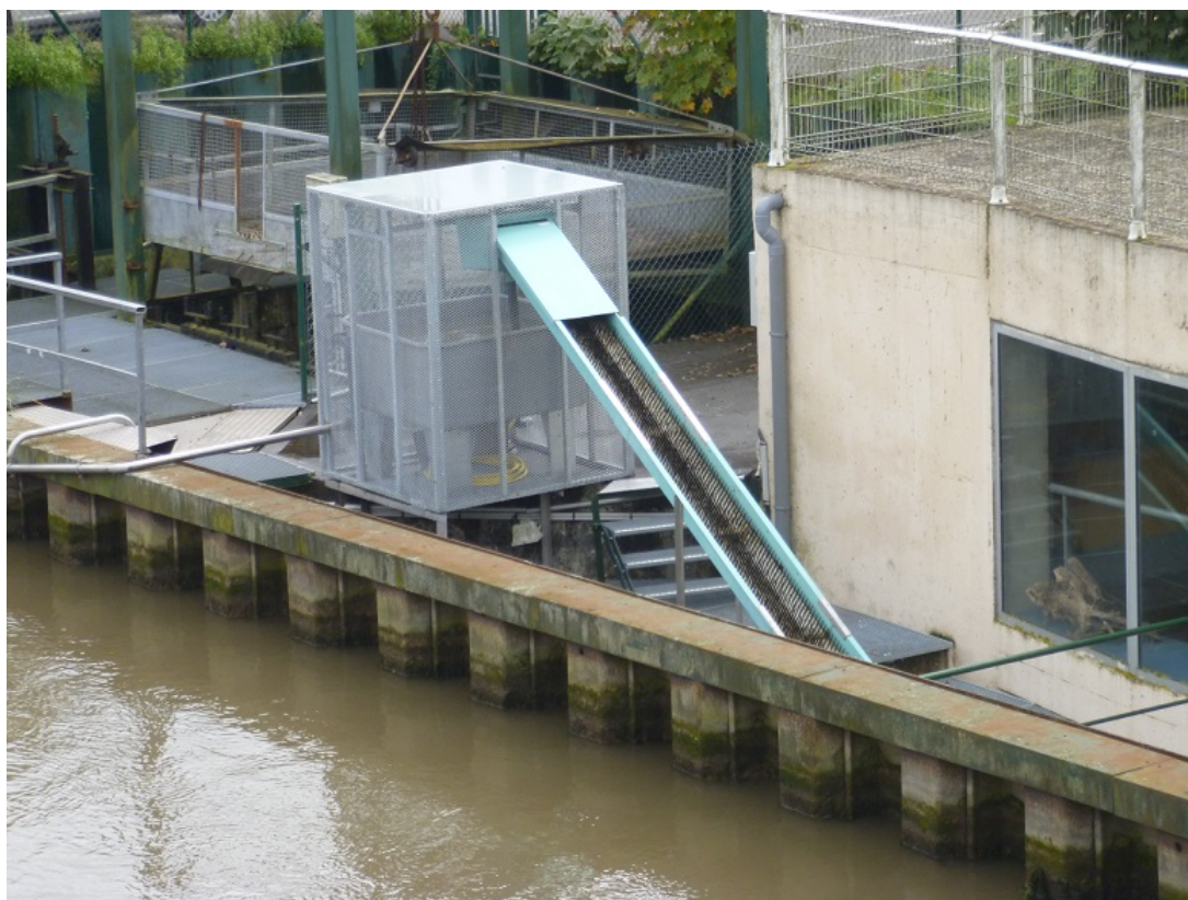
FIGURE 12 – Passe piège à anguilles en rive gauche du barrage de Poses - Amfreville-sous-les-Monts
