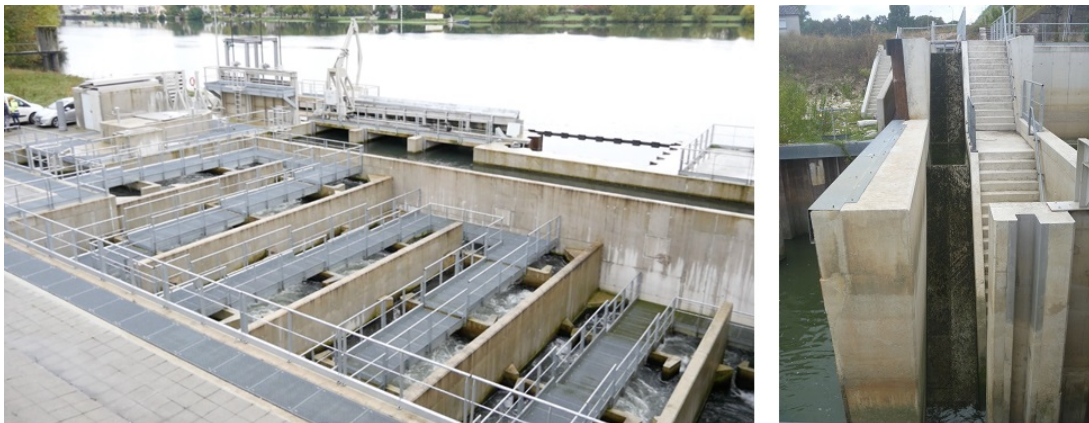
FIGURE 6 – Dispositif de franchissement en rive droite du barrage de Poses - Amfreville-sous-les-Monts. A gauche, passe à bassins à fentes verticales ; à droite, rampes de types « tapis-brosse »
